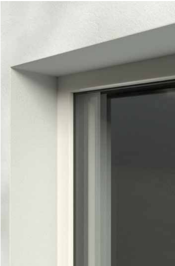
zichtbare montage van het frame met stelraam FIN-Fix
