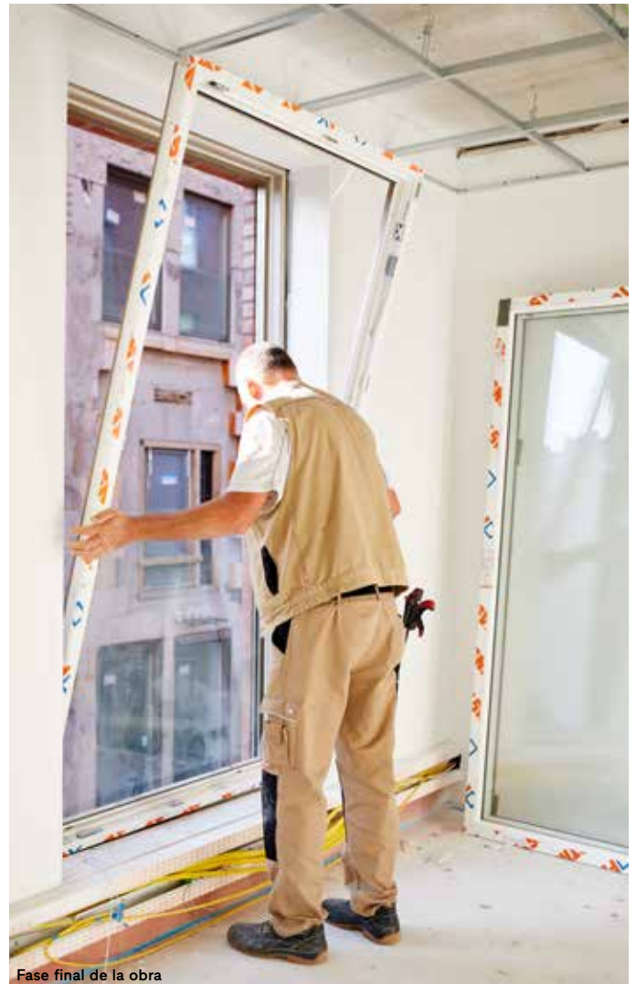
Fase final de la obra
