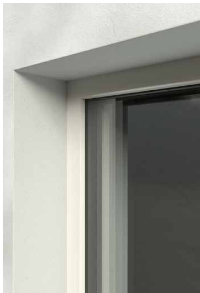
Montaje con premarco FIN-Fix con marco visto
