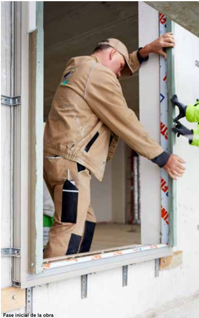
Fase inicial de la obra
