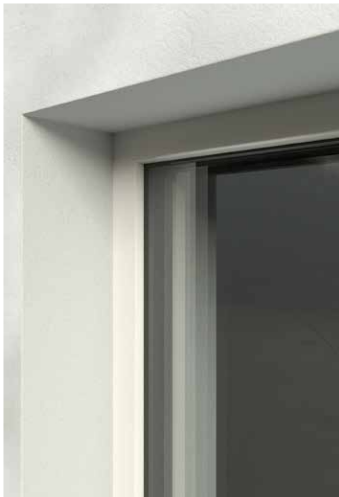
Pose dormant apparent avec précadre FIN-Fix
