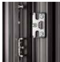
dispositivo anti-scardinamento
